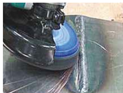
*移除焊接痕跡
